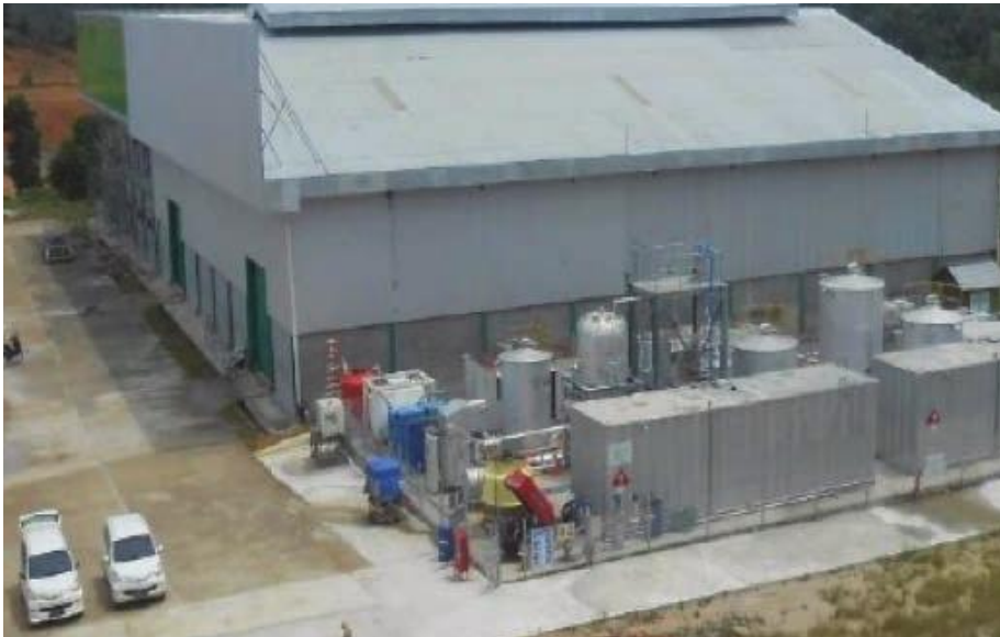
GAMBAR I. Demo Plant Daur Ulang Limbah Pelumas Bekas Menjadi Bahan Bakar Minyak
