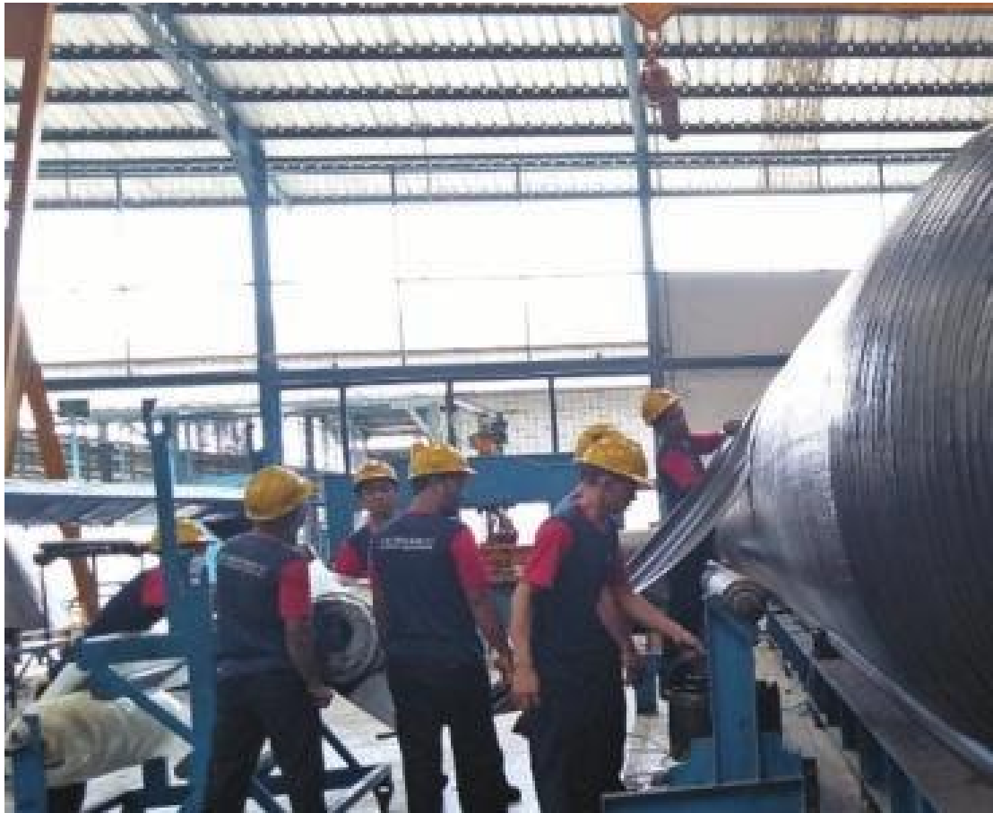
Gambar 2. Proses Pelilitan Rubber Air Bag dengan Mesin Pelilit
